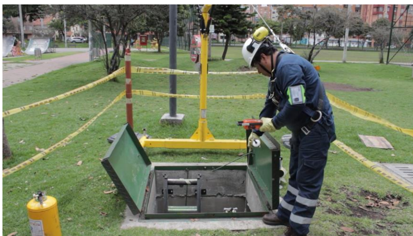
Fig. 5. Verificación de Atmosferas para garantizar el ingreso Seguro a la Estación
